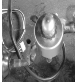
(b)电子膨胀阀
