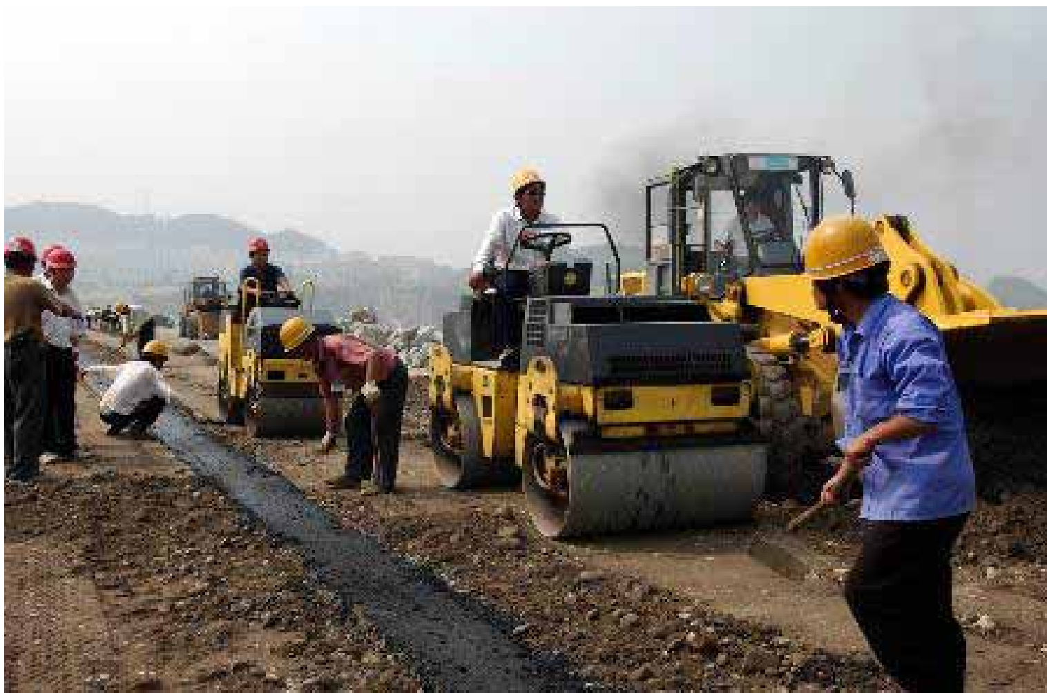
茅坪溪沥青心墙施工中
