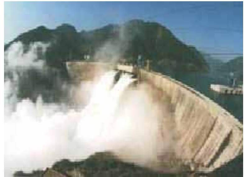
二滩水库大坝
