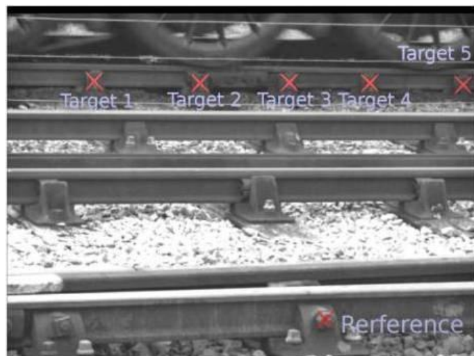
图 2-4 非接触视频测量仪在铁轨检测中的应用
