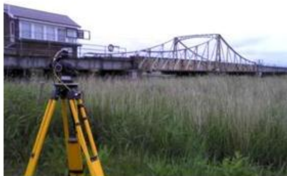
图 2-2 非接触视频测量仪在桥梁检测中的应用
