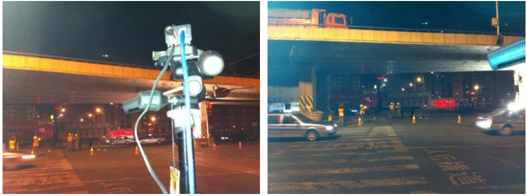
图 2-7 五一桥桥梁检测现场
