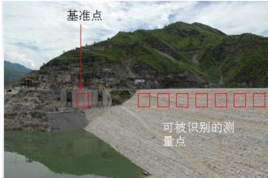
图 2-5 非接触视频测量仪在堤坝检测中的应用
